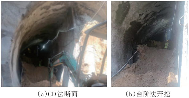
图 7 暗挖法隧道施工方式
