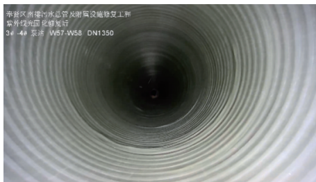
图6 修复后管道内情况
