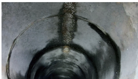
图1 原管道内部情况
