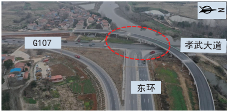
图5 G107—孝武大道-东环现状定向匝道实景图
