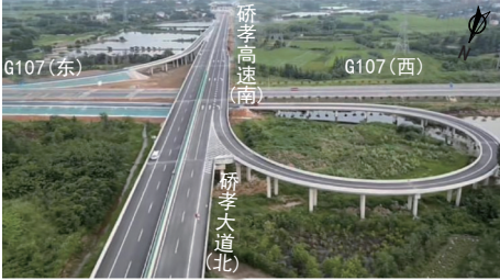
图6 桥孝高速—桥孝大道-东环现状节点方案实景图
