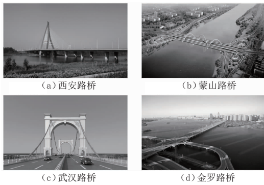
图7 通达路沭河桥上下游桥梁现状
