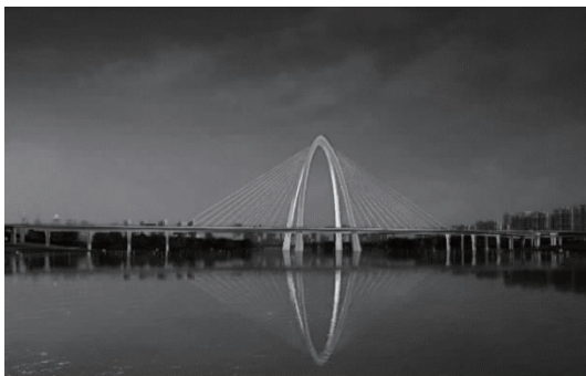
图8 四塔柱斜拉桥效果图
