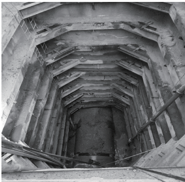
图4 现场工作井支护图
