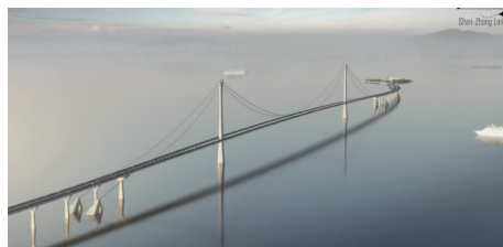
图9 主航道伶仃洋大桥之实景
