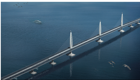
图 5 江海直达船航道桥之实景
