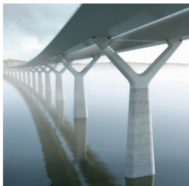
图10 非通航孔桥之实景
