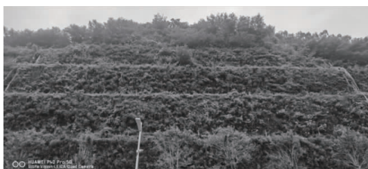
图8 五级边坡施工两年半,二~四级边坡施工一年半,一级边坡施工半年(雨季)
