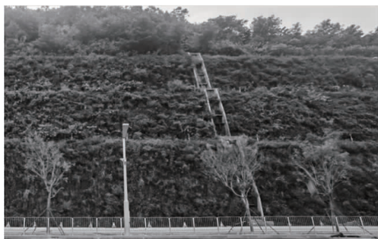
图6 植被混凝土施工一年半现场
