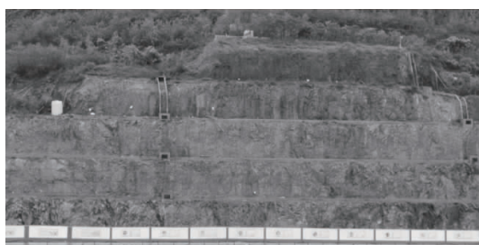
图7 一~四级边坡没有施工,五级边坡施工半年(秋季)
