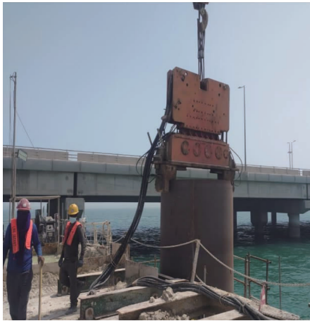
图5 200 kW 振动锤安装及跟进钢护筒施工 [7]
