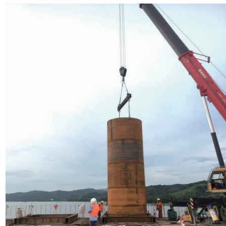
图4 钢护筒对接下放 [6]
