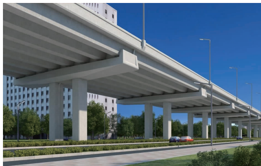
图1 标准段大悬臂倒T盖梁效果图
