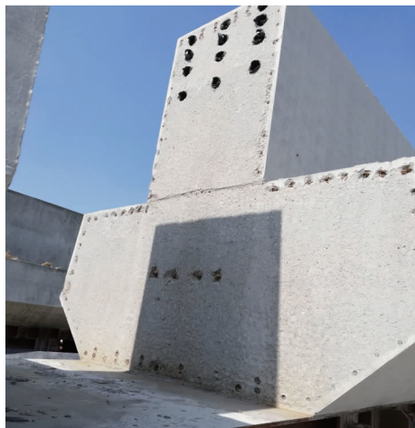
图 17 盖梁湿接缝处断面
