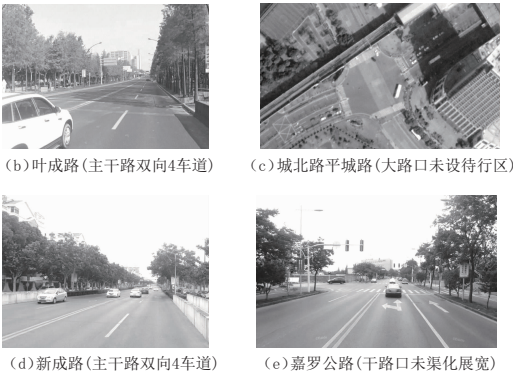
图7 嘉定新城现状道路设施情况
