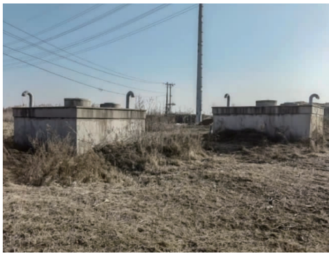
图 3 大伙房输水管线现状(地面构筑物)
