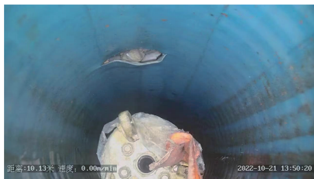
图2 气囊正在靠近修复点
