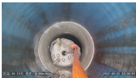
图3 非开挖修复完成
