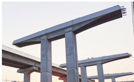
图2 预制盖梁实景图
