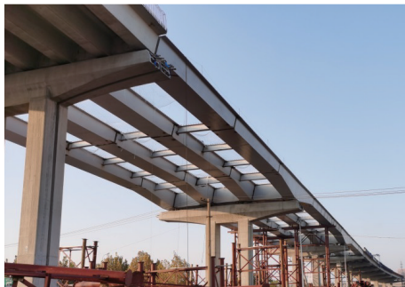
图3 组合钢箱梁施工现场
