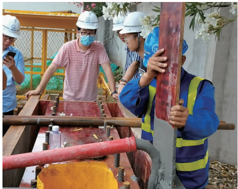
图 8 UHPC 泵送浇筑
