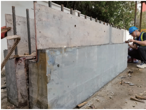
图9 UHPC湿接缝浇筑效果
