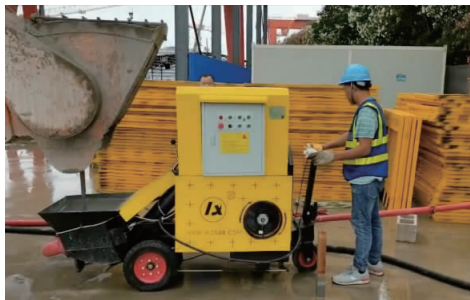
图 7 UHPC 卸入泵车
