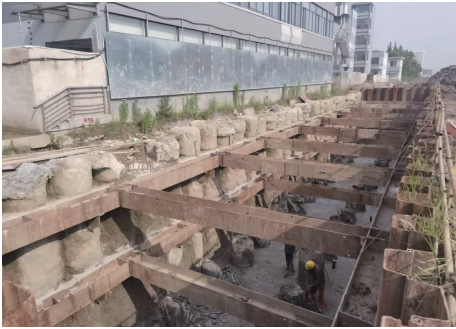
图 11 新型方案施工现场照片
