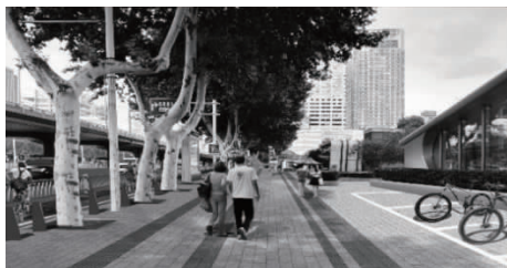
图5 人行道铺装提升
