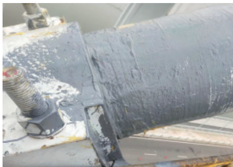
图8 主缆防护钢丝缠绕
