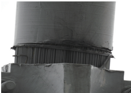
图2 吊索索夹径向滑移
