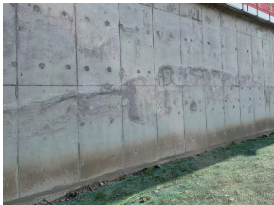
图2 混凝土观感较差
