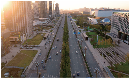
图7 武汉市高新大道海绵道路建设效果实景图2
