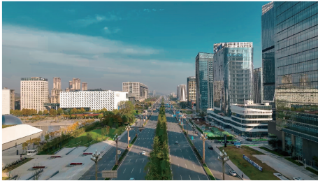
图6 武汉市高新大道海绵道路建设效果实景图1
