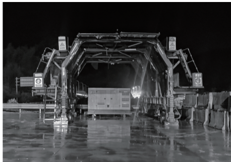
图7 智能施工台车设备图
