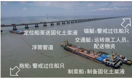
图 5 海上泵送固化土施工布置
