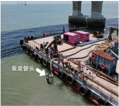
图 7 下放泵浆管头过程中
