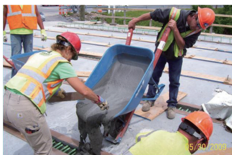
图6 小箱梁湿接缝 UHPC 施工
