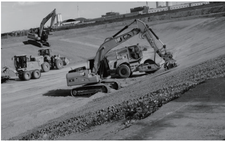
图6 液压夯实池壁
