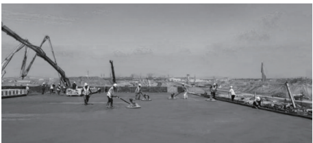
图10 磨光机收面之实景
