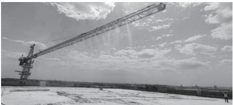
图11 塔吊喷淋养生
