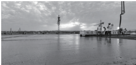
图5 混凝土布料摊铺之实景
