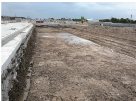
图12 整治现场工况图
