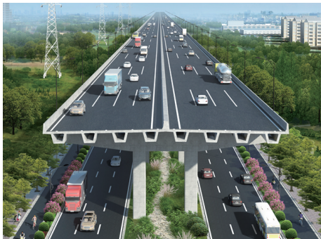
图1 主线高架工程断面效果图
