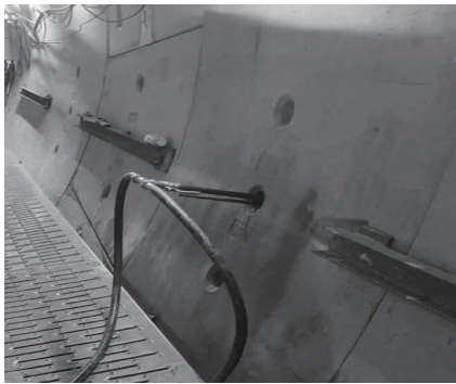
图8 洞门位置采用封闭注浆环管片
