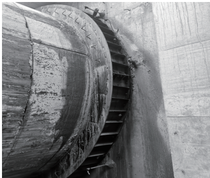
图7 短套筒+洞门周边预埋注浆管
