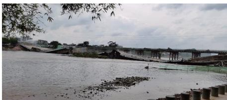
图6 爆破后桥梁垮塌解体
