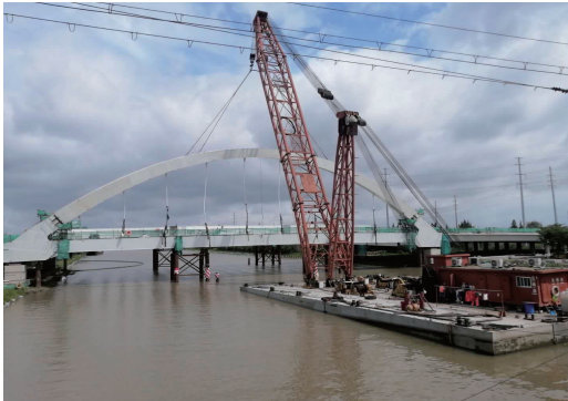
图 23 拱肋无支架整体吊装架设
