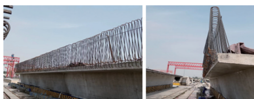
图10 护栏主筋提前预埋
