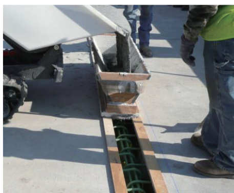
图7 横向35 cm缝宽+环形钢筋交错布置(不焊接)工艺
