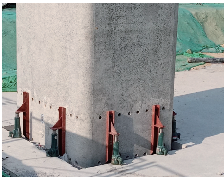
图17 立柱与承台采用灌浆套筒连接
