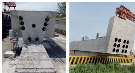
图9 深埋锚成孔后效果
