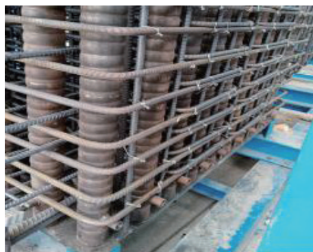
图16 立柱与盖梁采用灌浆波纹管连接
