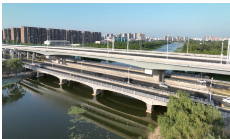
图13 古黄河大跨钢箱梁施工照片
