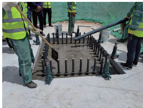
图15 立柱与承台开槽施工照片
