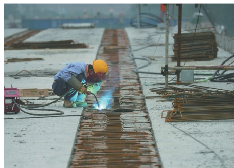
图5 传统大湿接缝工艺施工照片
