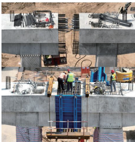
图19 主线标准双柱盖梁施工照片
