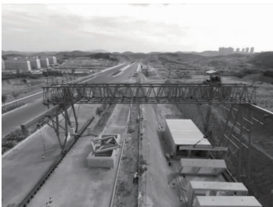
图3 龙门吊吊装全预制装配式综合管廊
