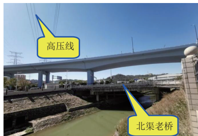
图9 主线上跨北渠、下穿高压线
