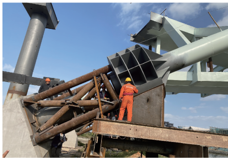
图5 拱脚拼接现场图
