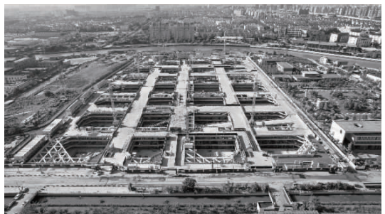
图 13 第四层土开挖施工图
