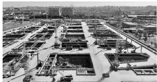
图 12 第一、二层土开挖施工图
