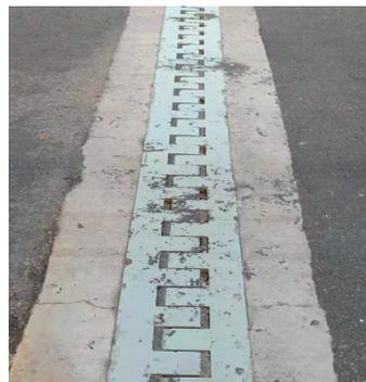
图4 某梳齿板伸缩缝安装槽开裂病害
