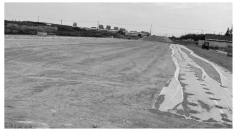
(a)填筑前实景
