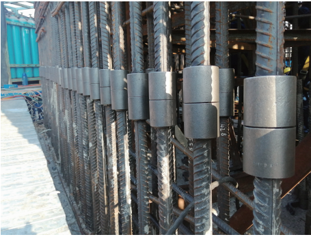
图 15 主筋锥套连接
