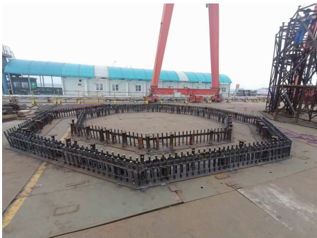
图 5 部品钢筋绑扎底座
