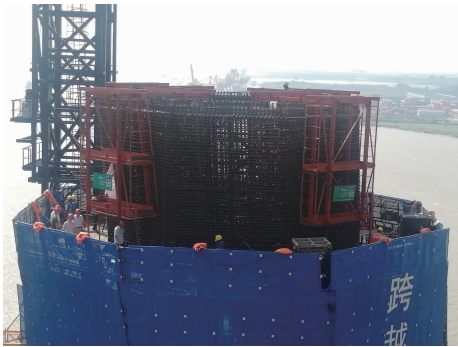
图 16 塔上箍筋绑扎
