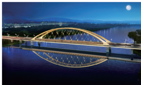
图4 网状吊杆拱桥夜景图
