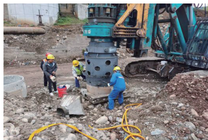
图9 跟进式护筒成桩工法下护筒照片
