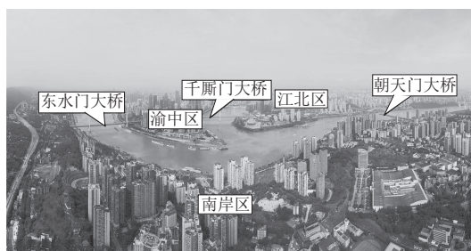
图1 两江三桥现状实景图
