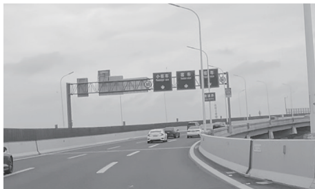
图6 东向北主线圆曲线内侧停车视距
