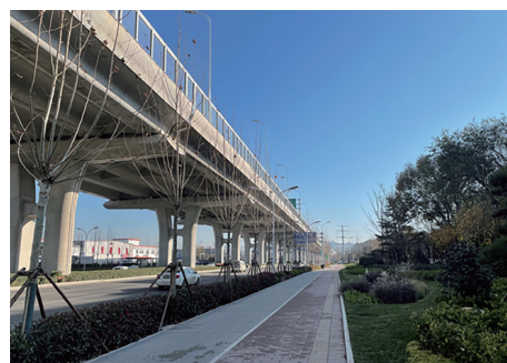
图 1 高架标准段:预应力混凝土小箱梁建成实景图
