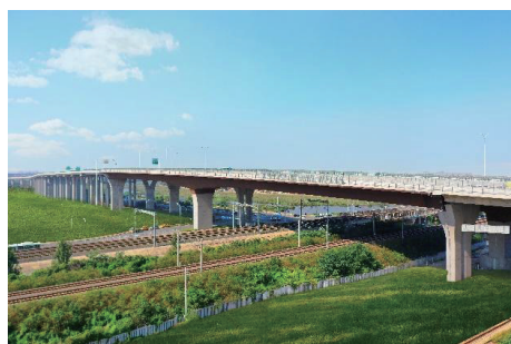
图8 跨铁路节点耐候钢转体桥建成实景图
