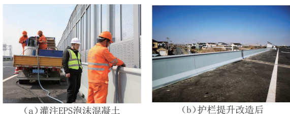
图13 灌注EPS泡沫混凝土后开放交通
