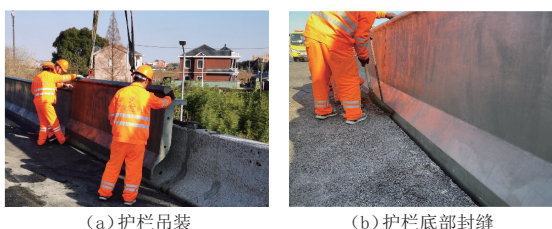
图12 UHPC现场安装
