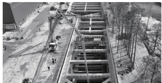
图 18 车行隧道现场施工照片
