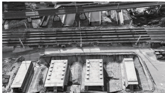
图13 人行通道和车行隧道顶推施工照片
