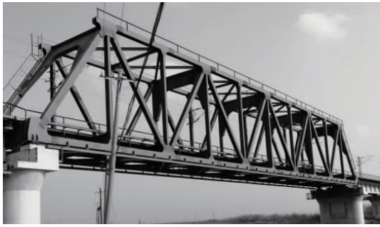
图1 钢桁梁桥全貌
