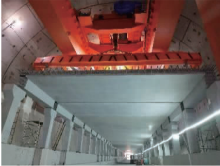
图 6 车道板安装
