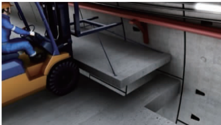
图 8 车道板施工
