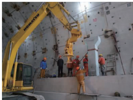
图4 立柱安装
