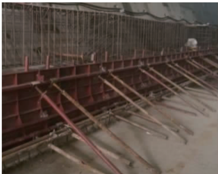
图3 现浇基座施工
