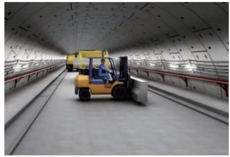
图 9 防撞墙安装
