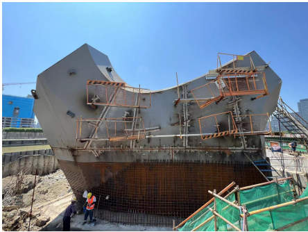
图5 P2拱墩结合段组焊
