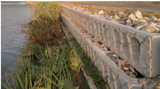
图5 预制箱型砌体堤防近景
