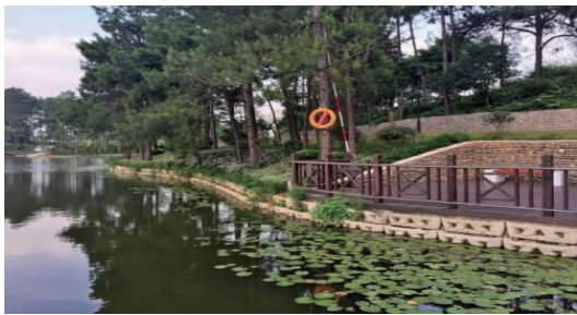
图4 预制箱型砌体堤防远景
