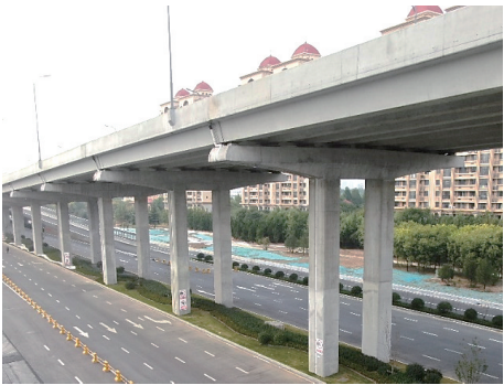
图 13 淄博市一环快速路高架桥实景图
