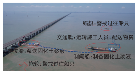
图5 泥浆固化土桩基防护施工现场布置照片
